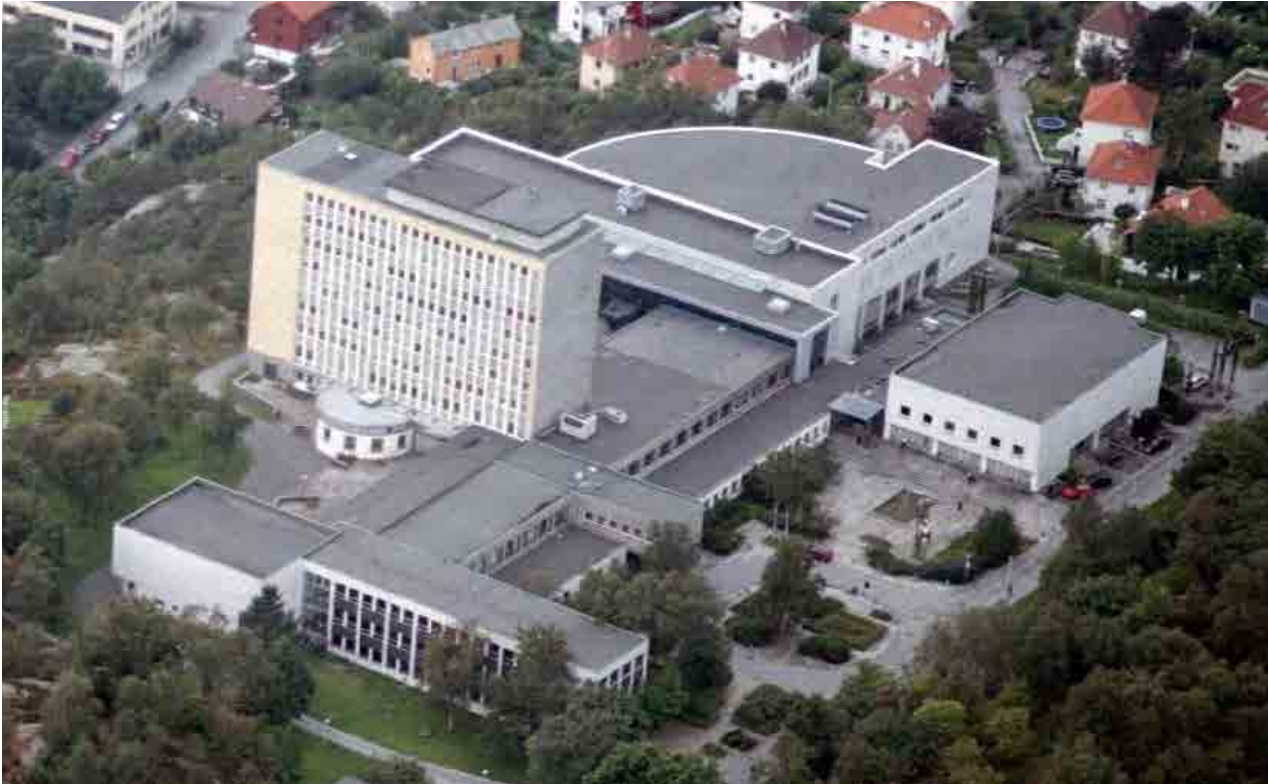
Norges handelshøyskole ble bygget av Nicolay Brøndbo og Paul Lambach. Skolen har fått en rekke tilføyelser siden det ble bygget, men bygningen har likevel bevart viktige trekk som gjør den bevaringsverdig. Foto: Bergen Kommune, Mapaid
