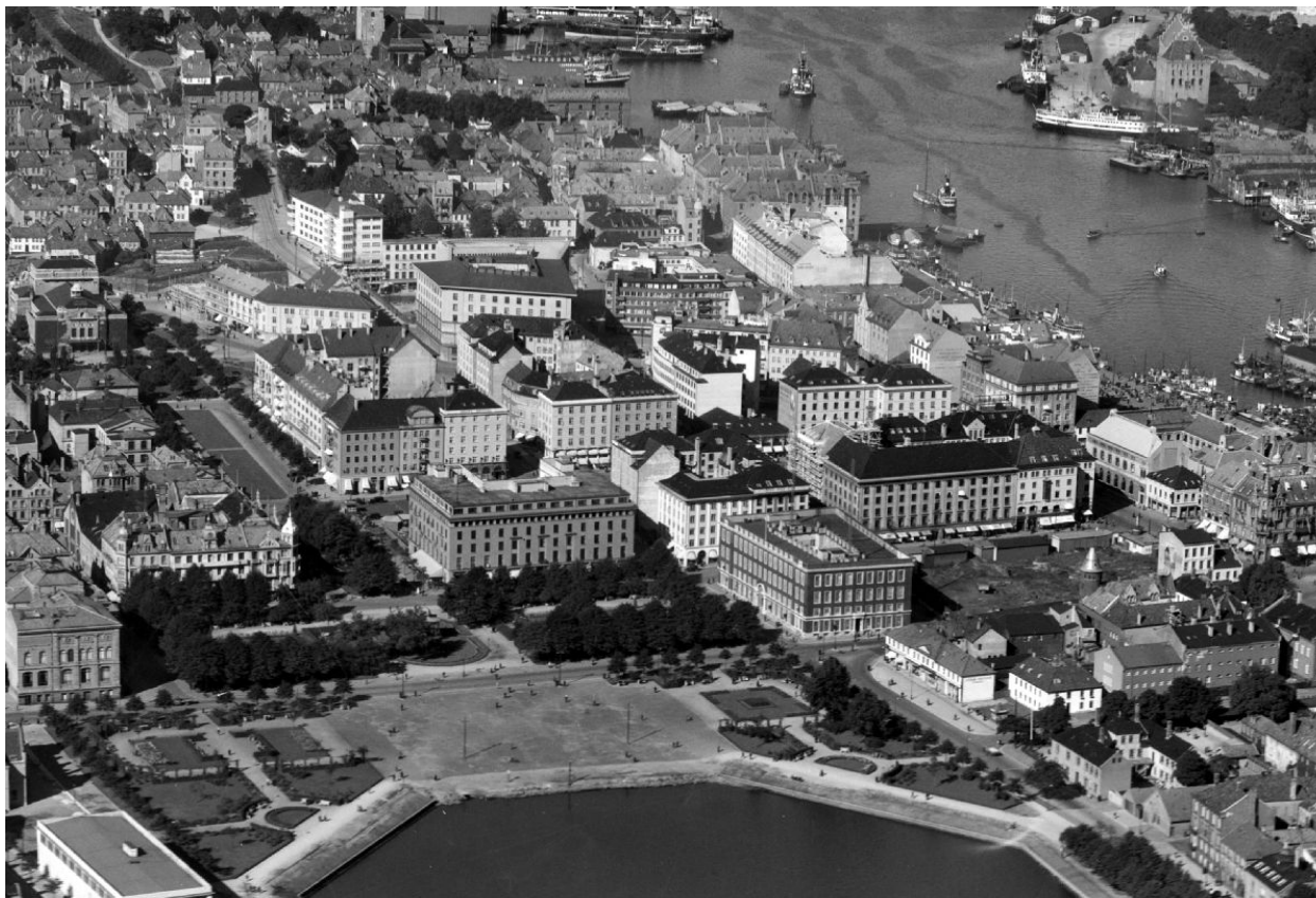
1916-området i 1935. Området sto lenge fram som noe helt spesielt i Bergens småskalabebyggelse. De høye, store kvartalene hever seg i forhold til den omliggende bebyggelsen. 1916-området er i stor grad inntakt og er et unikt område i norsk sammenheng. UBB-W-SH-005011
