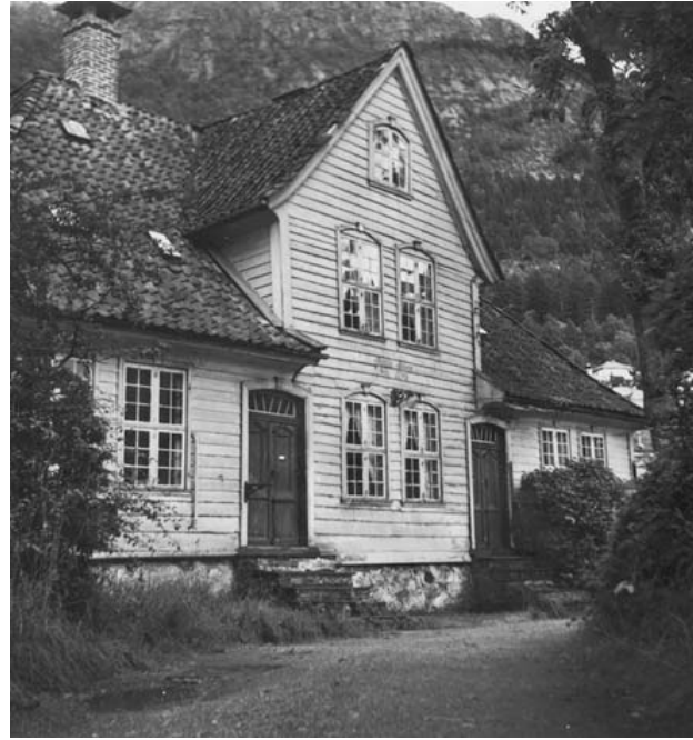
Måseskjæret i 1957 Hovedfasaden mot sjøen. Lyststedet Måseskjæret er en av de første fredningene vi har. Bygningen ble fredet i 1927. UBB-bros-002448A
