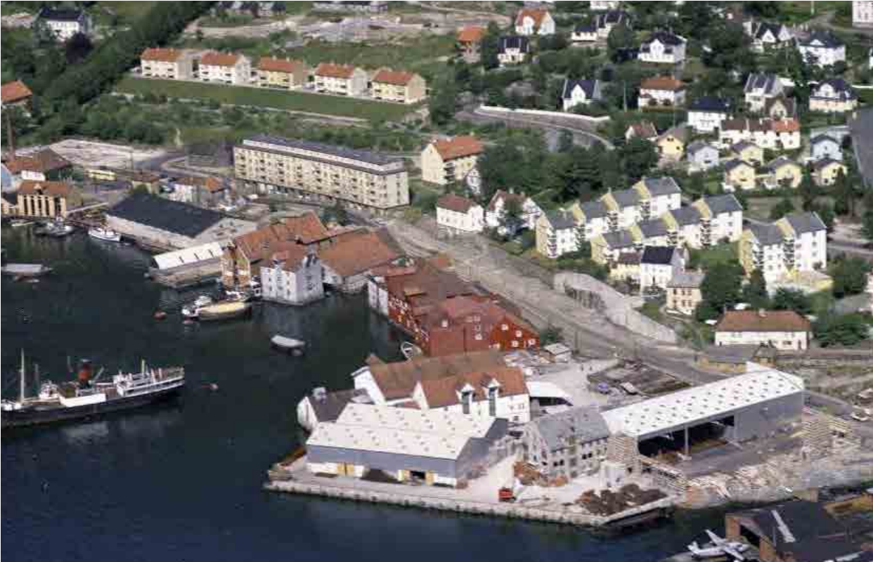
Neuman/arkitektskolen området i 1960: Sjøbodene vek for moderne industribygg på 1960-tallet. Sjøen ble fylt igjen og moderne kaier bygget. UBB-W-F-009470
